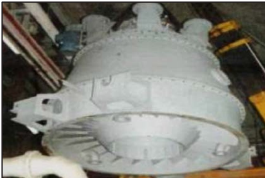
Sección clasificador antes de la protección.
