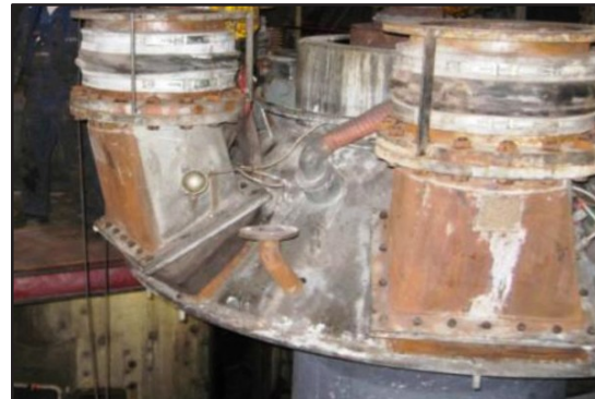
La sección superior protegida internamente con ARC está siendo bajada en su lugar.
